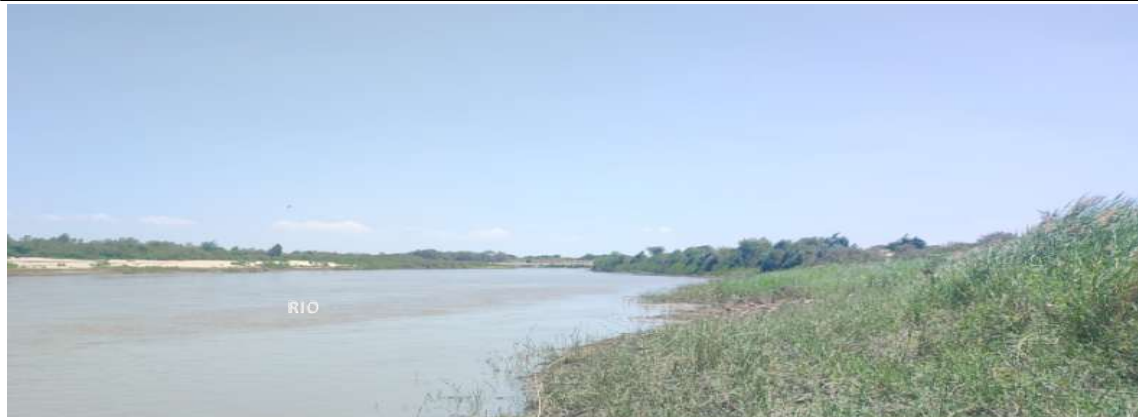
FIGURA N°01: TRAMO CRÍTICO EN EL RIO PIURA, EN SECTOR SECTOR NUEVO ZONA MORE - NUEVO SAN ANTONIO, DISTRITO DE LA ARENA, PROVINCIA DE PIURA - PIURA.
